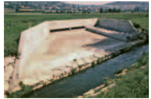
Abbildung 3.16: Mischwasserentlastung im Furtal/ZH. (Foto: AWEL, Zürich)
