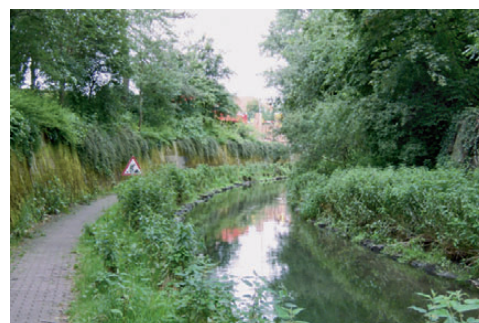
Abbildung 1.13: Chriesbach in Dübendorf: Um einen hohen Überschwemmungsschutz zu erreichen, wurde das Gewässer tiefer gelegt und begradigt. Die angrenzenden Gebäude lassen keine breite Uferzone zu. Der Hochwasserbereich des Bachbettes wird auch als Spazierweg genutzt.
