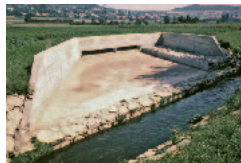
Figure 3.16: Déversoir d'orage dans le Furtal /ZH. (Photo: AWEL, Zürich).
