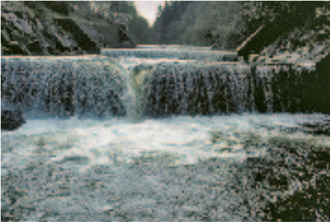
Figure 1.8: Constructions transversales dans un cours d'eau ayant pour conséquence d'empêcher les déplacements des organismes aquatiques.
