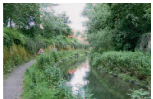
Figure 1.13: Chriesbach à Dübendorf: pour atteindre un haut degré de protection contre les crues, le ruisseau a été creusé et canalisé. Les constructions à proximité ne permettent pas de créer une zone riveraine. Le lit majeur est également utilisé comme voie piétonne.
