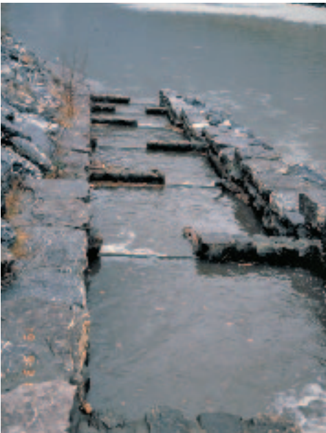
Figure 1.9: Exemple d'échelle à poisson.
