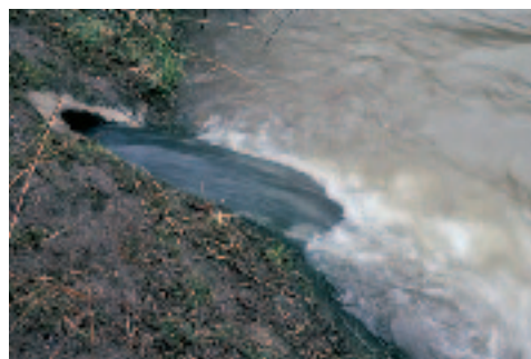
Figure 2.1: Rejets d'un déversoir d'orage dans un cours d'eau.
