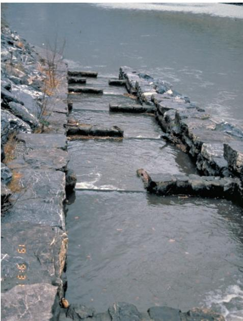
Figure 1.9: Exemple d'échelle à poisson.
