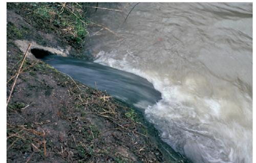
Figure 2.1: Rejets d'un déversoir d'orage dans un cours d'eau.
